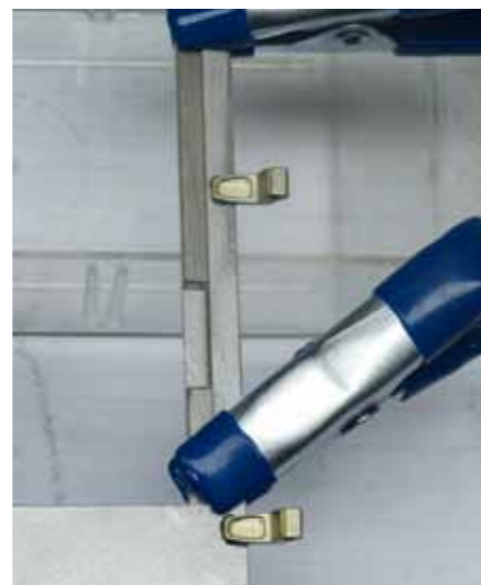
Die Scharniere müssen exakt positioniert werden, damit die Türen später auch gut schließen
