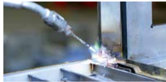
Hartlöten eines Finescale-Containers: Die Verfärbungen der Bauteile entstehen durch den Wärmeeinfluss der Flamme. Nach dem Sandstrahlen ist davon nichts mehr zu sehen
